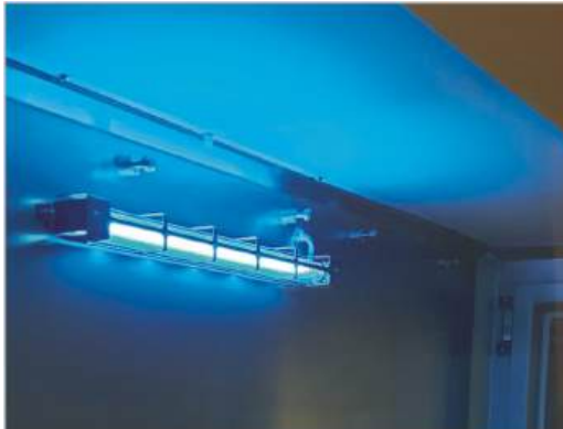
ЛАМПА УФ-ОБЛУЧЕНИЯ для дезинфекции поверхностей и материалов может устанавливаться как в рабочей камере, так и в проходном шлюзе для облучения, в том числе, донной поверхности передаваемых емкостей.
